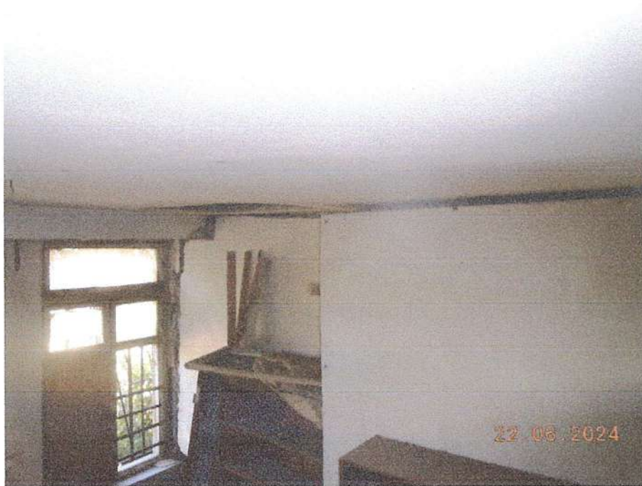
Նկ. 4 Շրջանակների սյուների ու պարզունակների միացման հանգույցներում տարանջատման ճաքերի տեսքը
